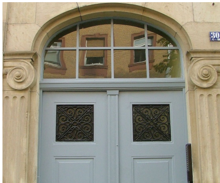
Das alte Hoftor in der Krappmühlstraße 30
